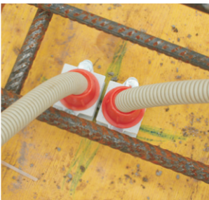
Пример использования концевых втулок и муфт.
