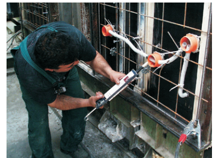
Герметизация вводов (отверстий).
