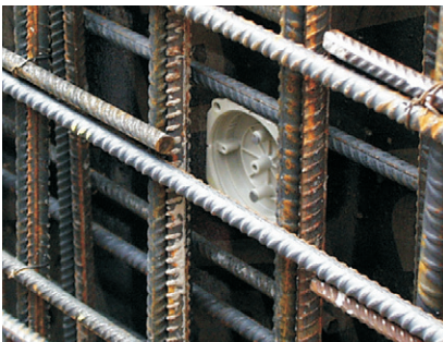
Крышка KBV, прикрепленная на опалубке.
