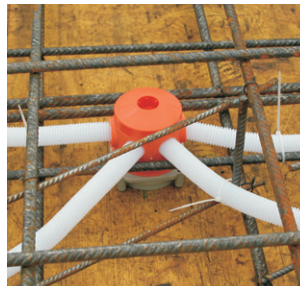
Пример установки в горизонтальной опалубке.
